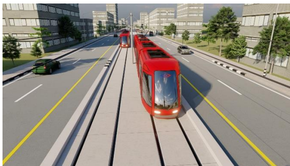
รูปที่ 6-2 รูปแบบทางวิ่งระดับดินบนแนวเกาะกลาง
